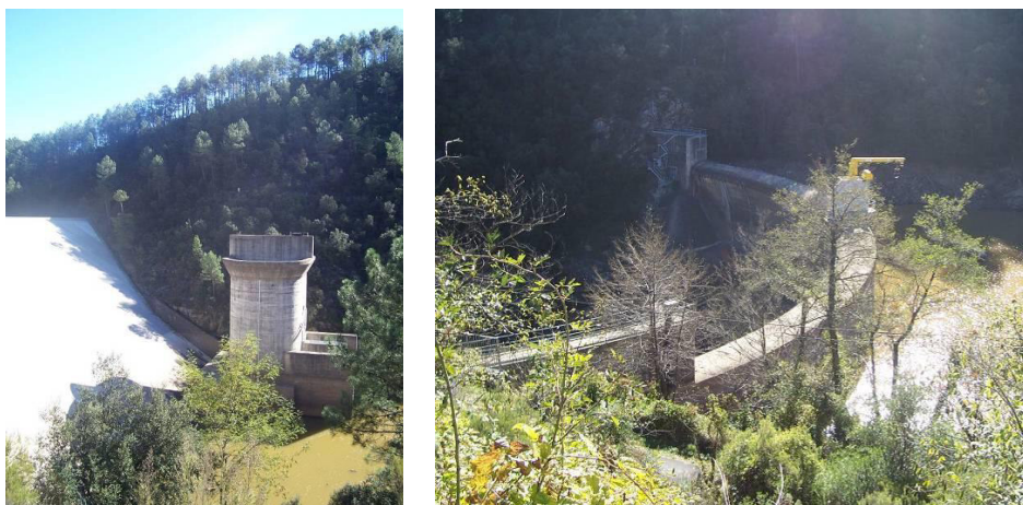
Figure 31 : Photos du barrage de Ste-Cécile-d'Andorge et des Cambous
