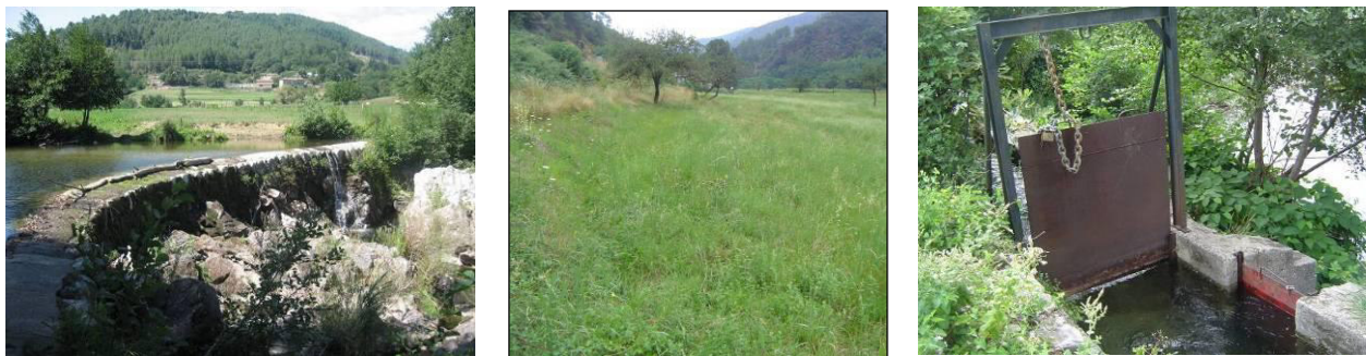
Figure 32 : exemples de prélèvement par béals sur le bassin versant des Gardons (seuil de prélèvement à gauche - prairie irriguées au centre - béal à droite)
