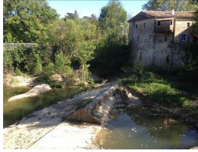
Ouvrage infranchissable sur la Droude à Brignon
