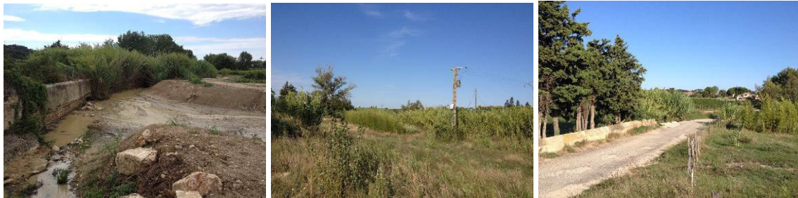
Confluence avec la Mayre / Ripisylve dégradée (canne de Provence) / Ouvrage à supprimer
