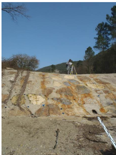
Un des seuils du Rieusset après travaux
