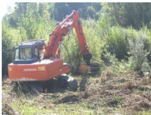
Scarification d'un atterrissement
