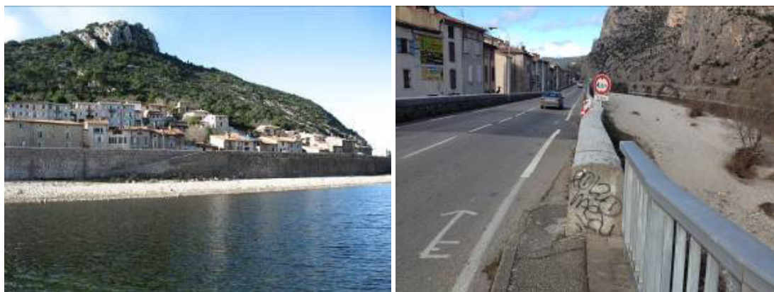
Digue d'Anduze vue de face et en crête
