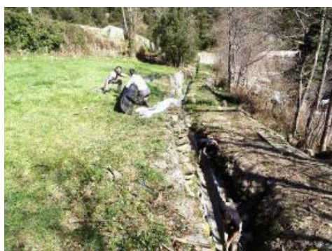
Appui Equipe verte pour la mise en place de demi-buse sur le béal du Mazauric
