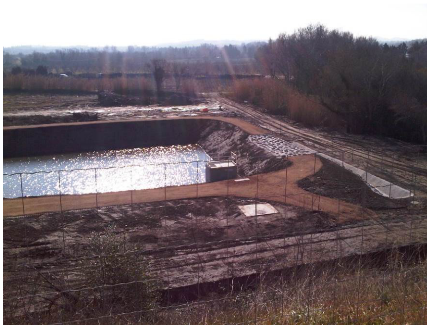
Bassin de rétention des eaux de l'A9 sur Fournès (peu après les travaux – source : ASF)
