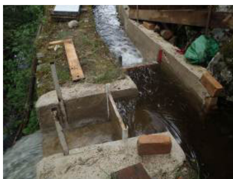
Système rustique de respect du débit réservé installé sur le béal du Mogador (Salindrenque)
