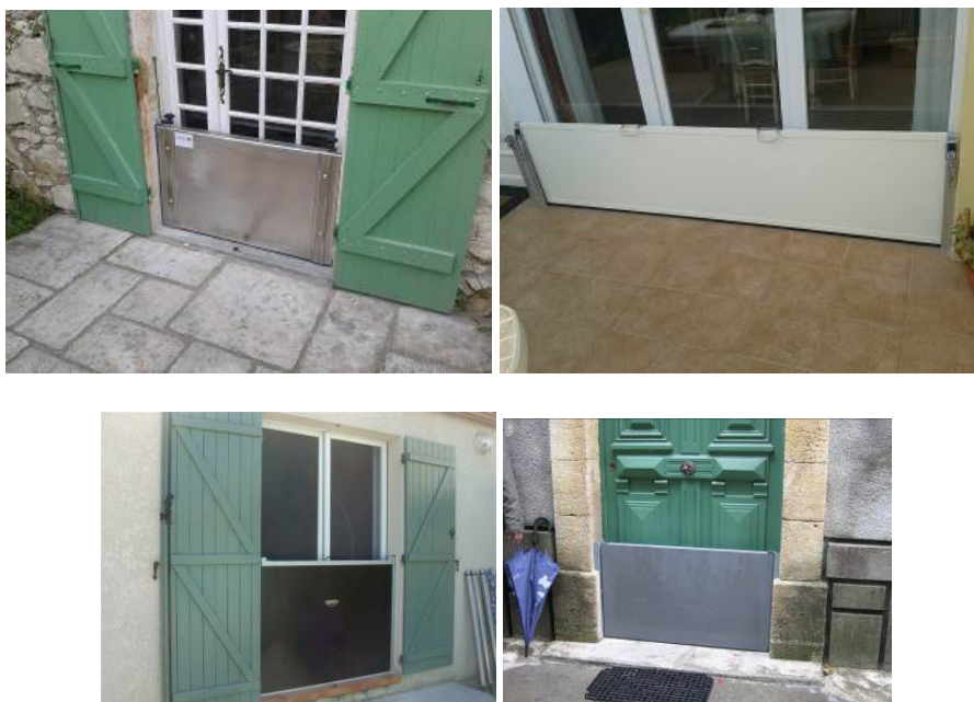
Exemples de batardeaux posés dans cadre d'ALABRI en Gardonnenque
