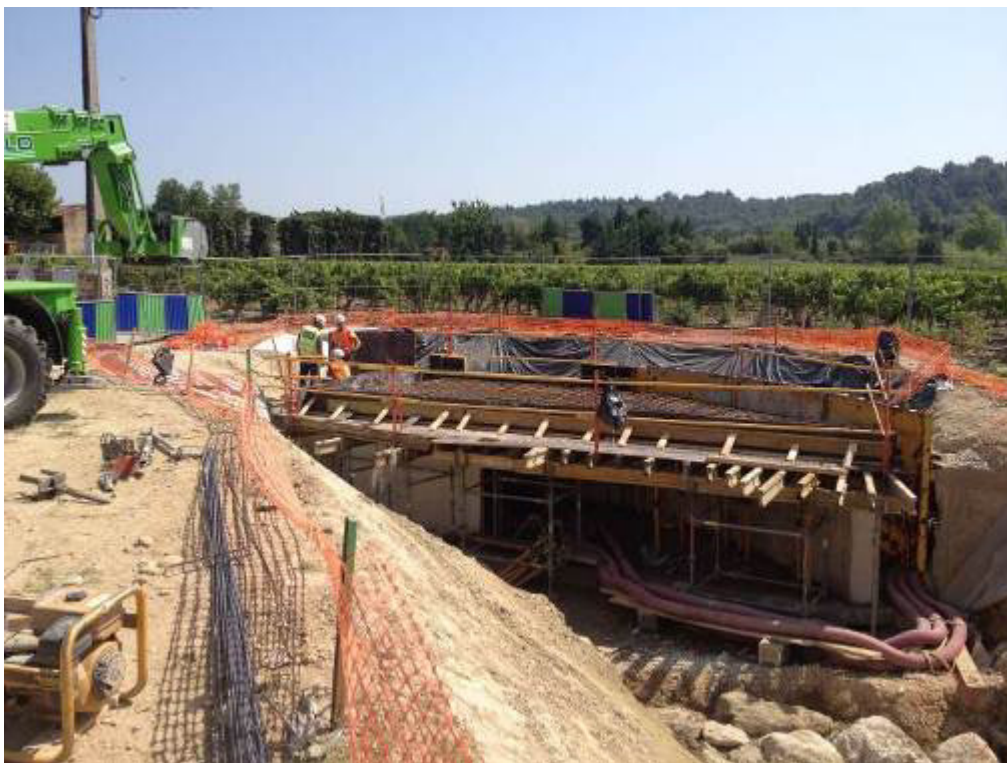
Ouvrage de mise à ciel ouvert du Briançon
