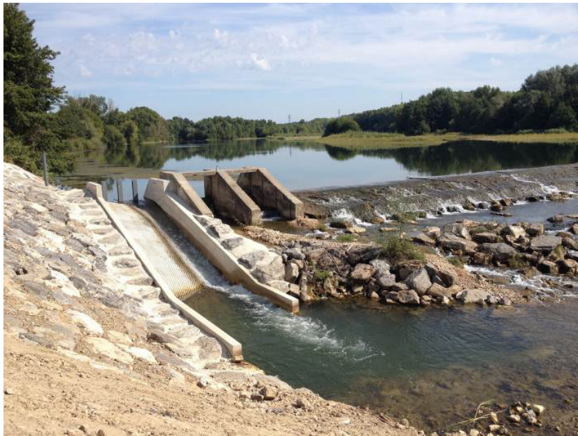
Passé à anguille du seuil de Cassagnoles
