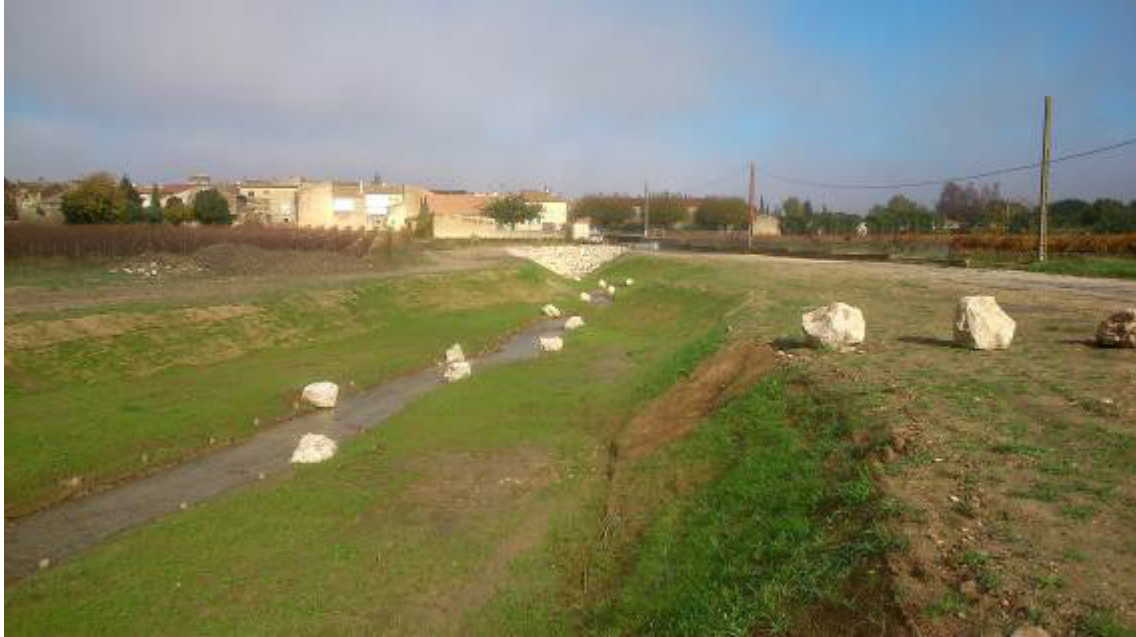
Nouveau lit du Briançon
