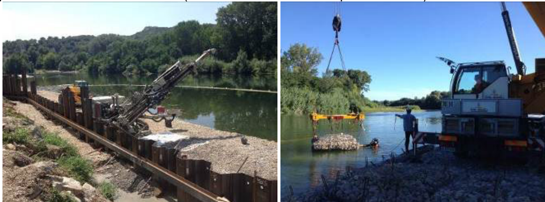
Phase chantier – rideau de palplanches tirantées et pose de matelas Réno
