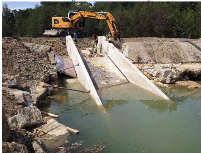
Passé à anguilles sur le seuil de Saint Chaptès en cours de réalisation
