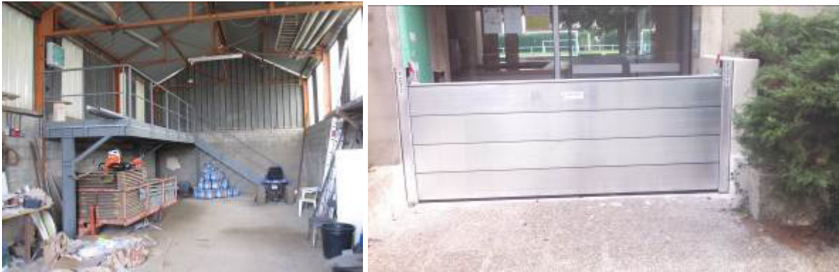
Mezzanine et batardeaux posés à Cardet
