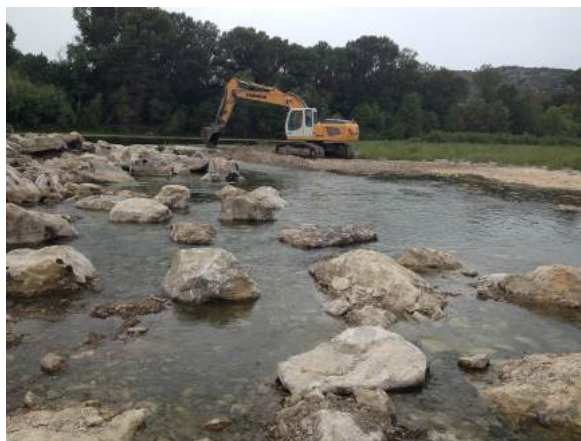
Réaménagement du seuil de Fournès pour le rendre franchissable par l'Alose
